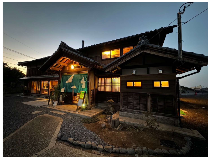
▲ 建物は大谷製油所の創業家の母屋を改装
