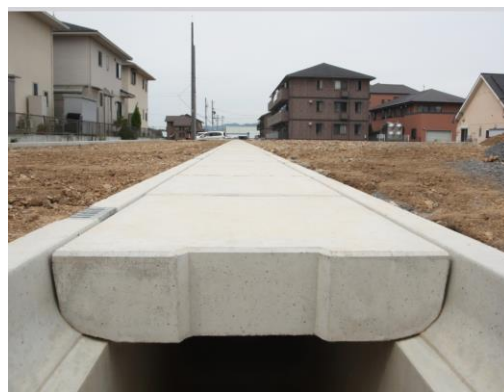
実際に施工された『リボーン側溝』の様子。しっかりとした安定感も窺える
