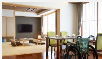
室内の段差を解消
