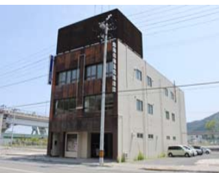
補助金を活用して復旧した釜石商工会議所会館（24 年 4 月撮影）
