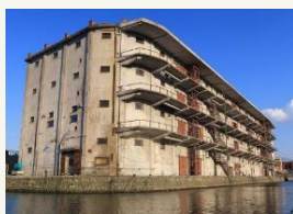
▲小樽運河のシンボルの倉庫（市指定歴史的建造物）
