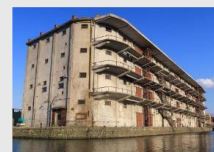
▲小樽運河のシンボルの倉庫（市指定歴史的建造物）
