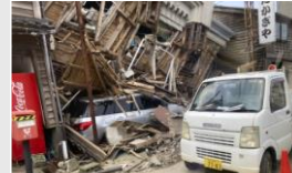
▲火災被害のあった朝市通り（上） 崩壊建物が残る市内（下）
