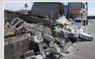
▲水産加工業・倉庫の倒壊
